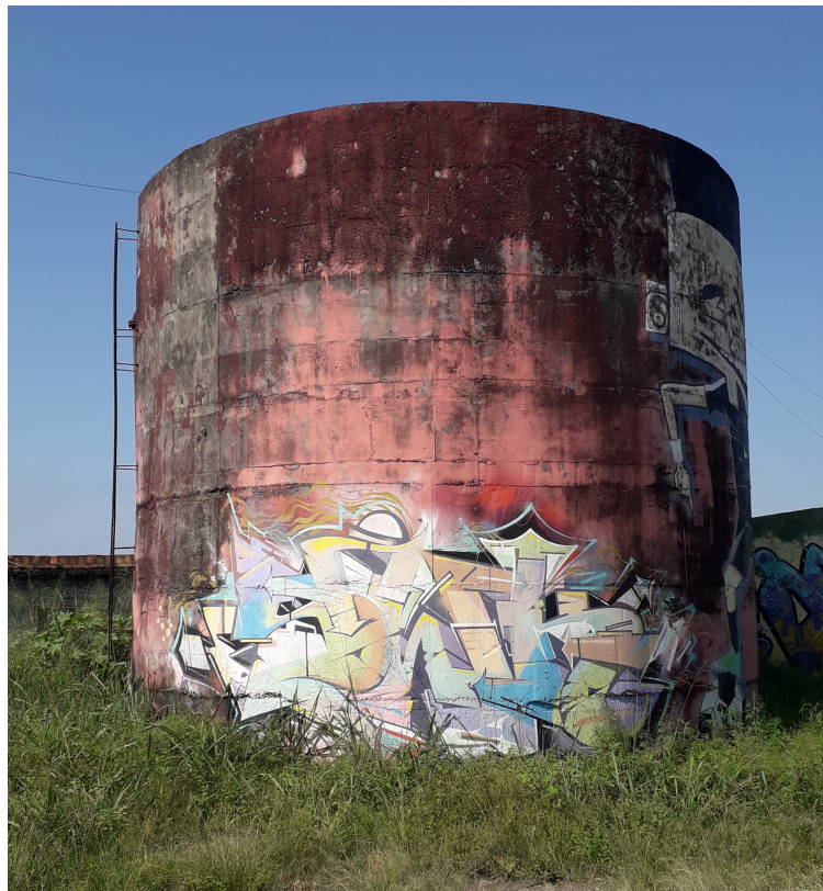
Figura 1 Cisterna abandonada. Arquivo pessoal, 2019
