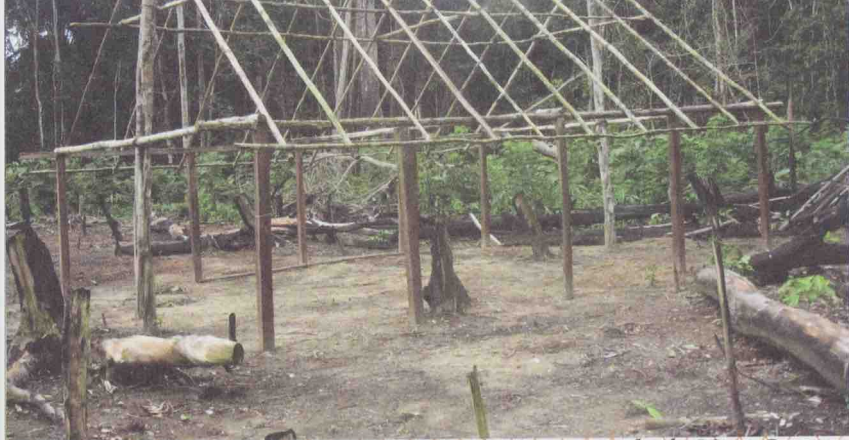
Construção de escola, já no estado do Mato Grosso.
